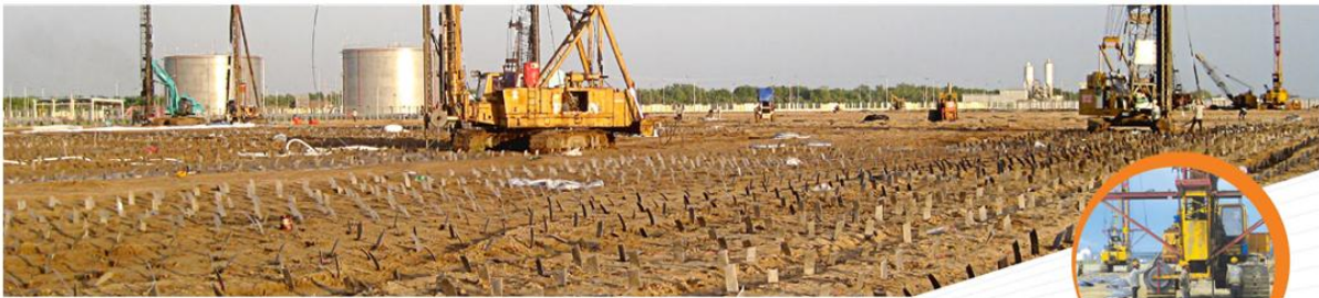
Hình 3.8. Công nghệ vải địa kỹ thuật và bắc thấm
