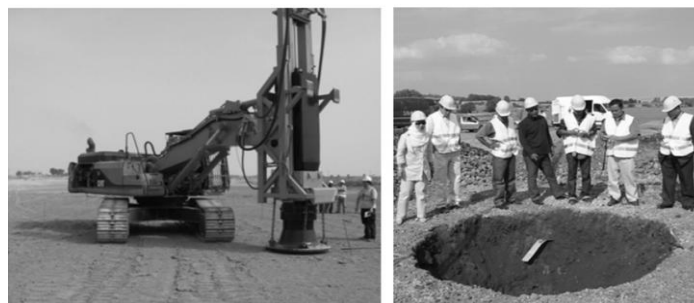
Hình 3.3. Máy đầm rung và kết quả đầm trong thực tế
